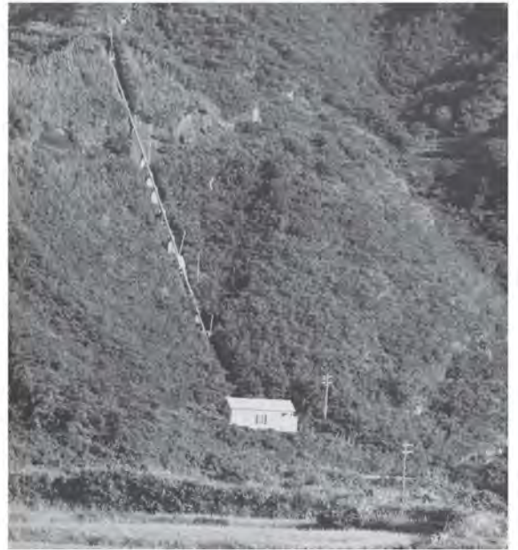
大賀郷の水田の奥にあった毛串山水力発電の施設（八丈支庁所蔵写真）
